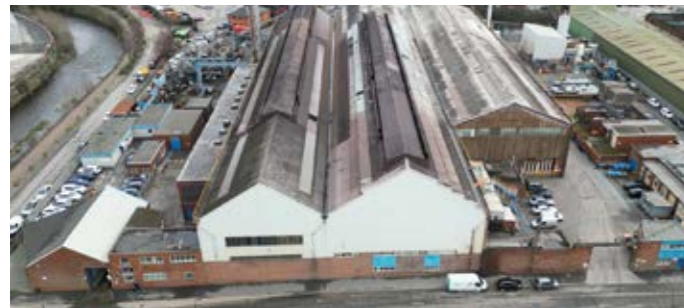
ASR wire rod mill
