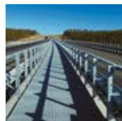
BARRIERE DI SICUREZZA
