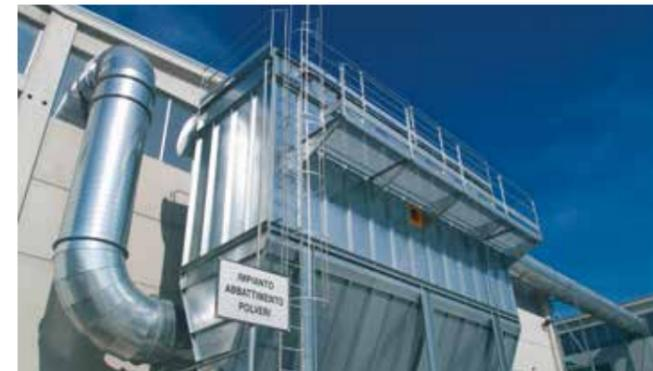
La rimozione finale degli inquinanti acidi, metalli pesanti e la depolverazione dei gas di combustione avviene nel sistema di trattamento fumi posto a valle della caldaia.
