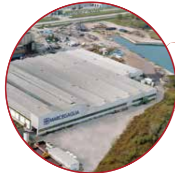
MARCEGAGLIA PLATES PLANT San Giorgio di Nogaro (UD)
